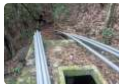
Trilliumpro @Proyek PDAM Negara (Bali)
